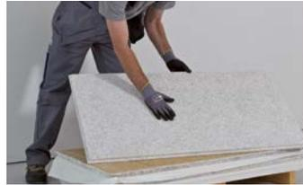
**Platte auf Beschädigungen überprüfen. Eventuell anhaftenden Staub mit weicher Bürste entfernen.**
