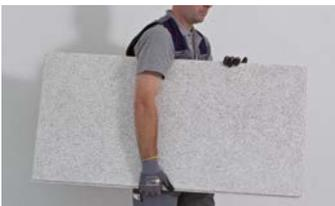
**Akustikplatten beim Abheben vom Stapel nur hochkant tragen. Platten beim Abheben vom Stapel niemals über die Stapelkante ziehen, um eine Beschädigung der Sichtseite zu vermeiden.**
