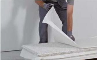
**Einlagepapier sorgfältig von der Platte abziehen und gleich entsorgen. Darauf liegender Staub darf nicht auf die darunter liegende Platte fallen.**
